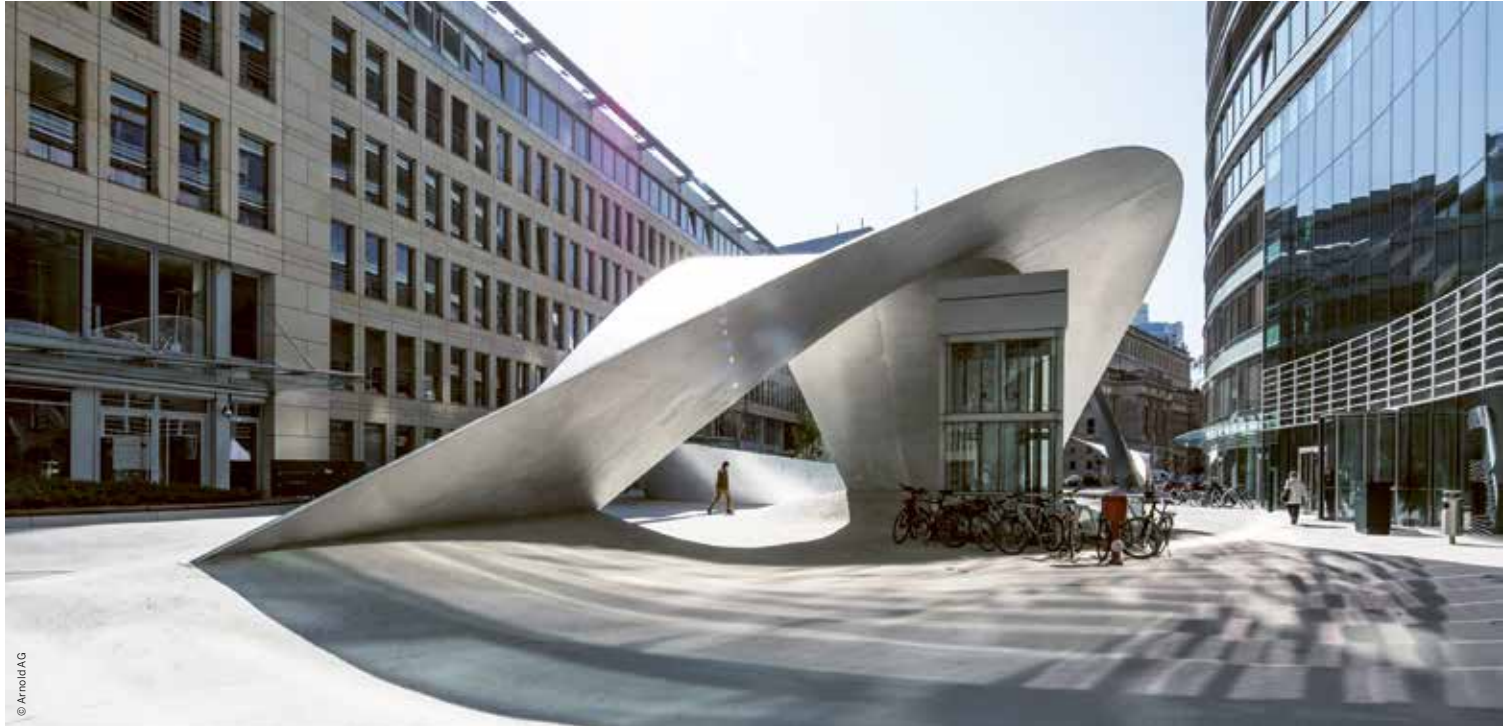
Nahe der Alten Oper in Frankfurt erstreckt sich das Skulpturenensemble „Welle“. Entworfen vom Frankfurter Architekturbüro schneider+schumacher, realisiert von der Arnold AG.
